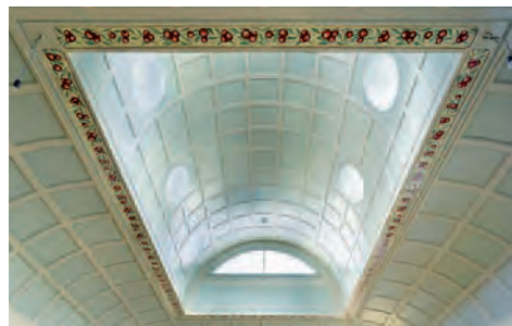
Abb. 132: Chur, Bahnhofsgebäude. Kassetierte Tonne im Zentrum der Bahnhofbuffet-Decke. Nachzustand.
