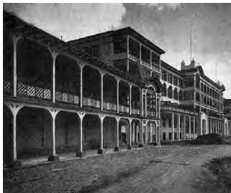
Abb. 114: Davos Platz, Hotel «Schatzalp». Südfassade. Abbildung in der Schweizerischen Bauzeitung 39/1902.
