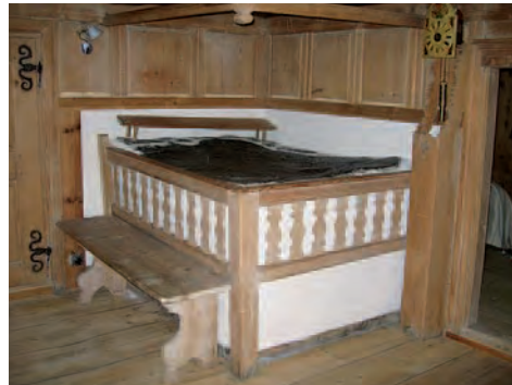
Abb. 138: Safien, Innercamana, «Nüw Huus» Nr. 169. Der Stubenofen. Nachzustand.
