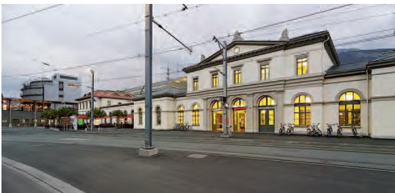
Abb. 129: Chur, Bahnhofsgebäude. Blick gegen Westen. Nachzustand.
