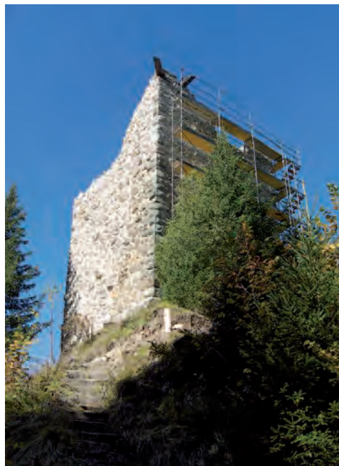
Abb. 142: Zillis-Reischen, Burgruine «Tur», während der Konservierungsarbeiten. Blick gegen Südwesten.
