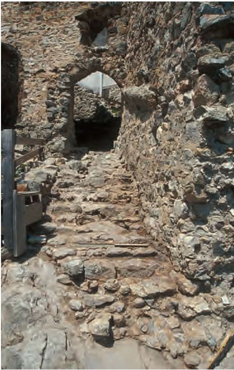
Abb. 47: Brienz/Brinzauls, Burganlage Belfort. Südtrakt. Gewölbter Treppen- abgang. Blick gegen Norden.
