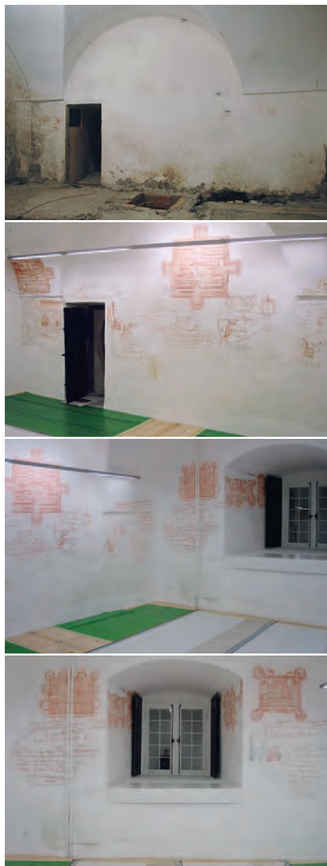
Abb. 67: Chur, Bischöfliches Schloss, Marsölturm. Ansichten der West- und Nordwand vor und nach der Restaurierung.
