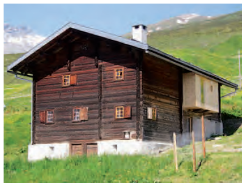
Abb. 137: Safien, Innercamana, «Nüw Huus» Nr. 169. Blick gegen Südwesten. Nachzustand.
