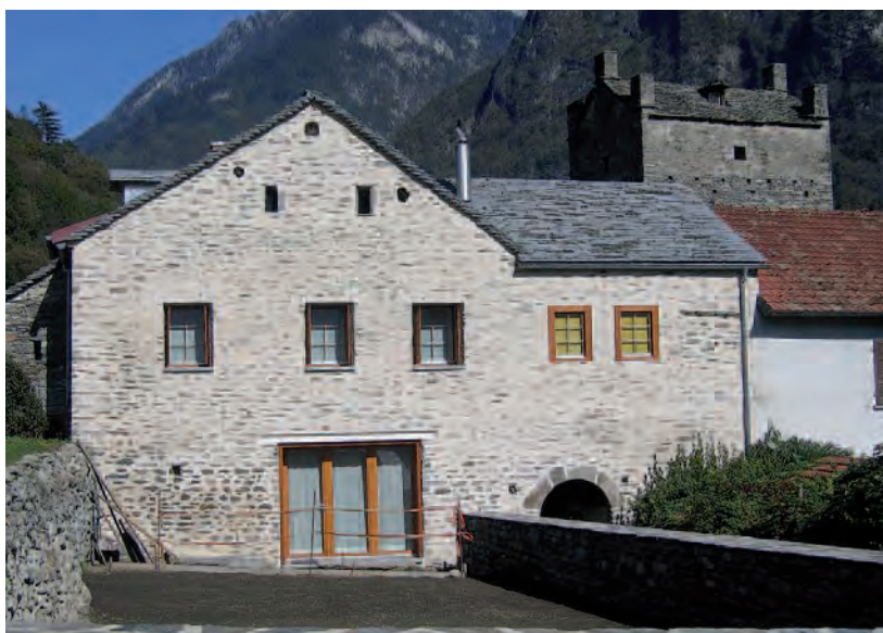
Fig. 133: Grono, casa no. 198 alla «Torr». Facciate principali.
