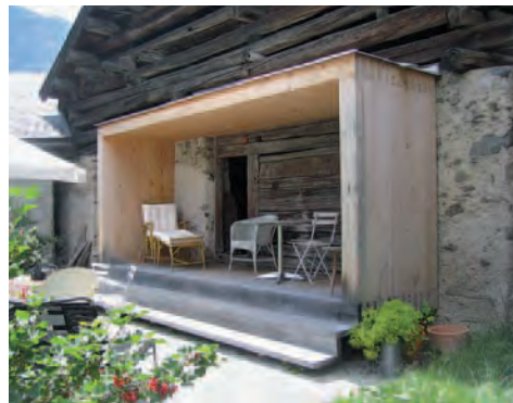
Abb. 122: Bergün/Bravuogn, Latsch, Haus Nr. 3. Neuer Terrassenanbau an der Giebelfront der Stallscheune.
