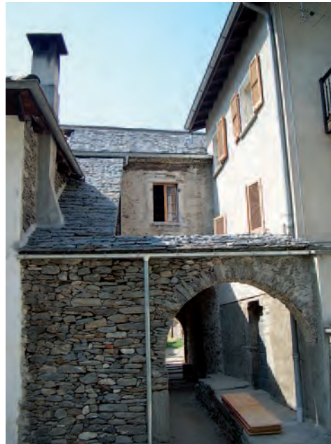
Fig. 134: Grono, casa no. 198 alla «Torr». Portico d'entrata.
